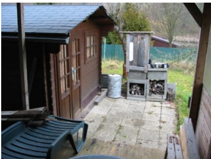
stavba zahrádkářské chatky bez čp/če - pohled od JZ na upravenou plochu u ZCH
