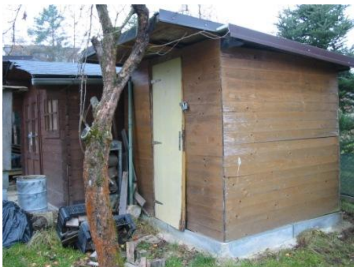
stavba zahradního domku na nářadí - pohled od JV-V z pozemku zahrady parc.č. 5263/66
